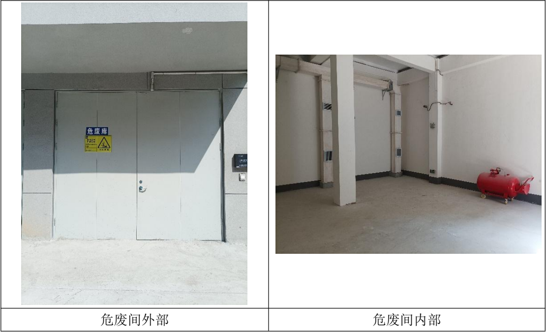
图 8-2 危废间现场照片
