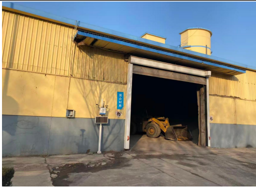
图 8-5 炉渣及脱硫石膏暂存库
