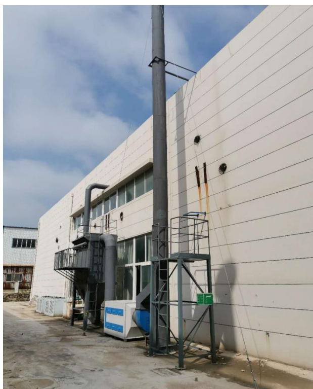
图4-8 现有工程排气筒采用平台
